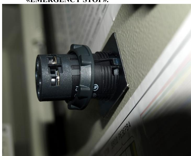
Рис.6. Установка прижимной шайбы и гайки на кнопку «EMERGENCY STOP».
