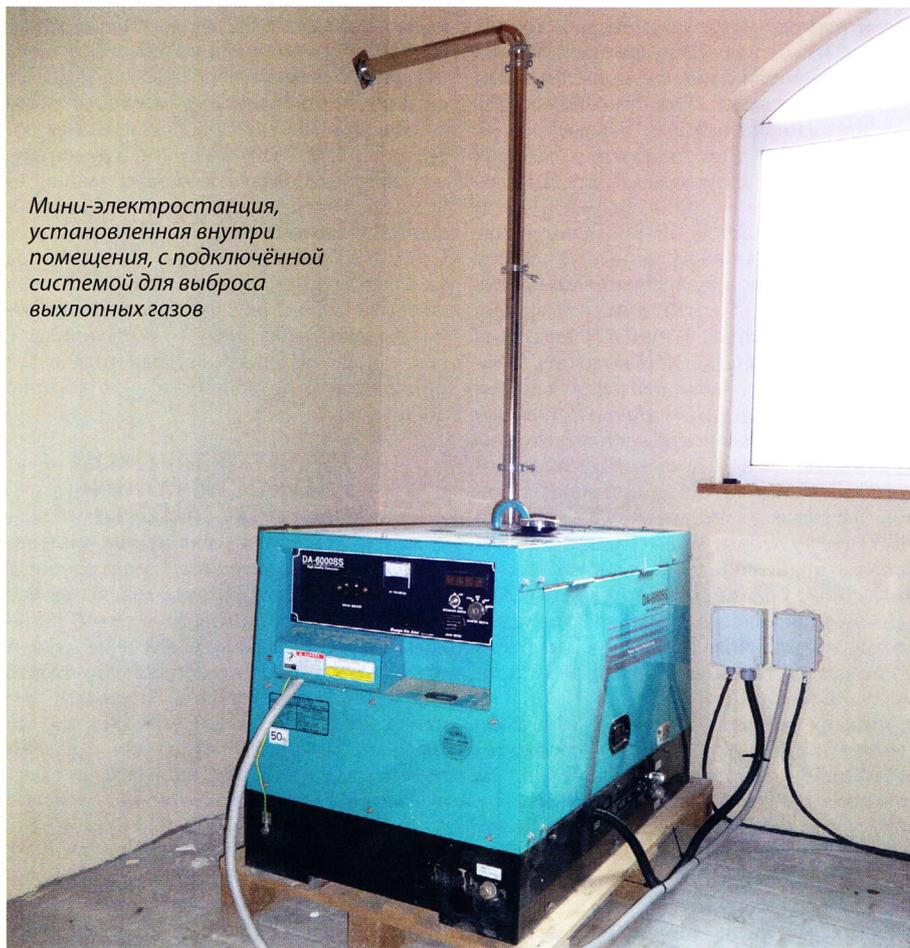
Мини-электростанция, установленная внутри помещения, с подключённой системой для выброса выхлопных газов
